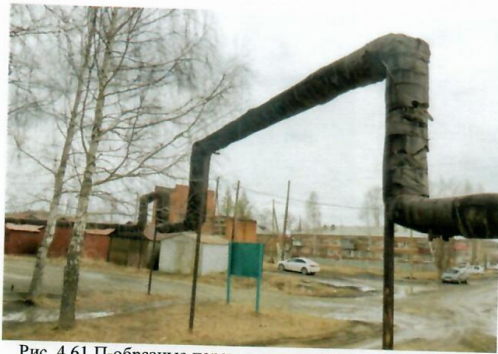
Рис. 4.61 П-образные переходы магистрали теплосети над проезжей частью
