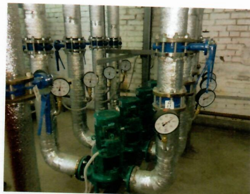
Рис. 4.54 Насосы рециркуляции
