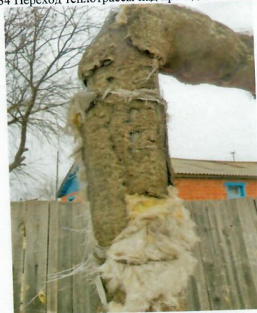
Рис. 4.136 Разрушение теплоизоляции
