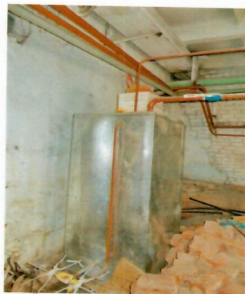
Рис. 4.23 Ёмкость под дизтопливо (не используется)
