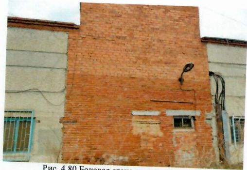
Рис. 4.80 Боковая стена здания котельной
