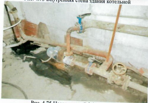
Рис. 4.75 Насос сетевой 1 (основной)
