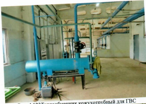
Рис. 4.123 Теплообменник кожухотрубный для ГВС
