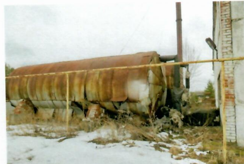
Рис. 4.108 Цистерны для воды 2х50 куб.м. (не используются)
