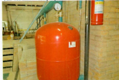
Рис. 4.90 Мембранный бак расширительный 200л
