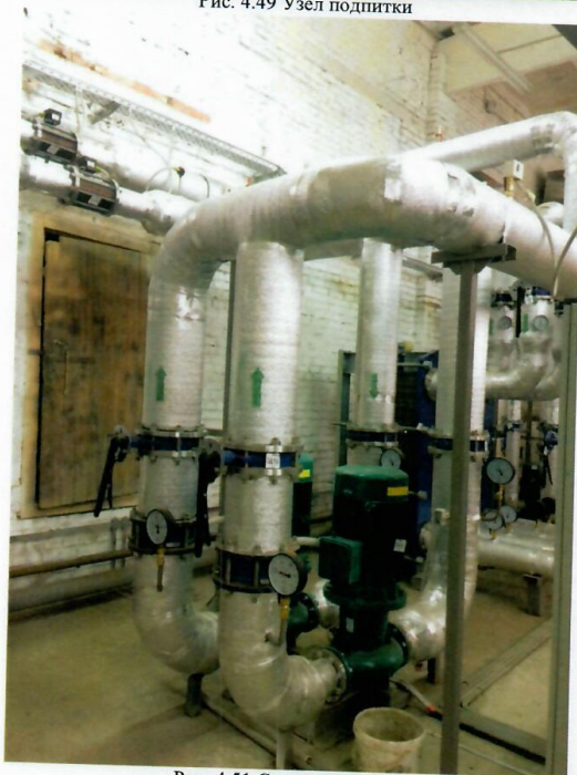
Рис. 4.51 Сетевые насосы
