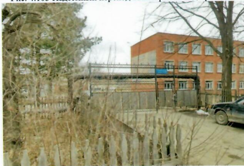
Рис. 4.105 Въезд на территорию училища к котельной
