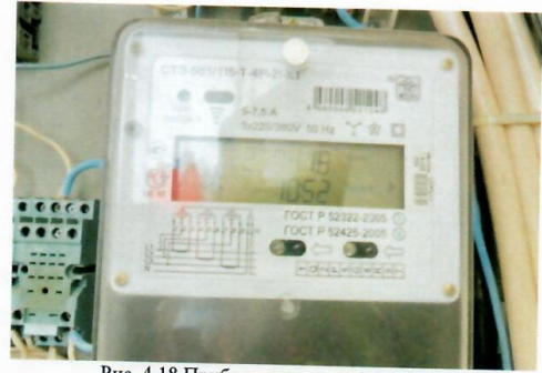
Рис. 4.18 Прибор учета электроэнергии
