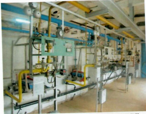
Рис. 4.117 Котлы водогрейные с газовыми горелками
