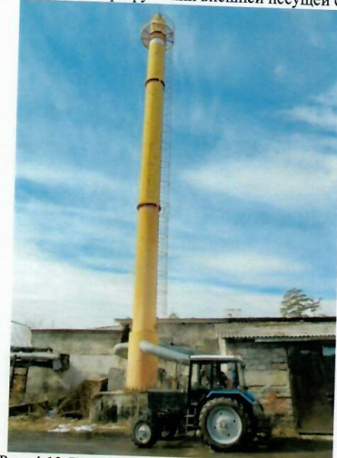
Рис. 4.12 Дымовая труба (установлена в 2006г.)
