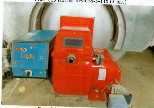
Рис. 4.15 Горелка газовая Unigas
