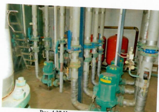
Рис. 4.27 Насосы рециркуляции
