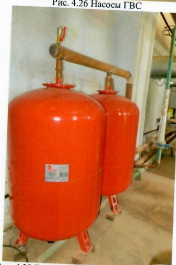
Рис. 4.28 Баки мембранные расширительные
