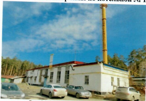
Рис. 4.1 Общий вид здания котельной
