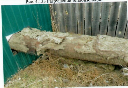
Рис. 4.135 Разрушение теплоизоляции
