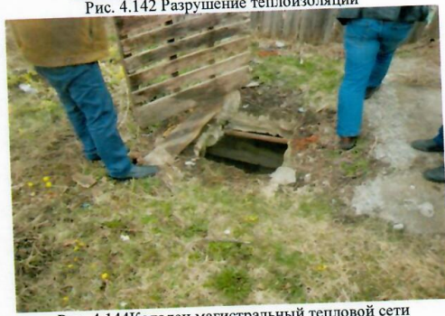
Рис. 4.144 Колодец магистральный тепловой сети
