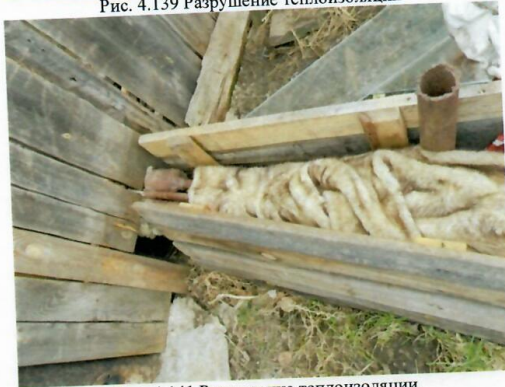
Рис. 4.141 Разрушение теплоизоляции
