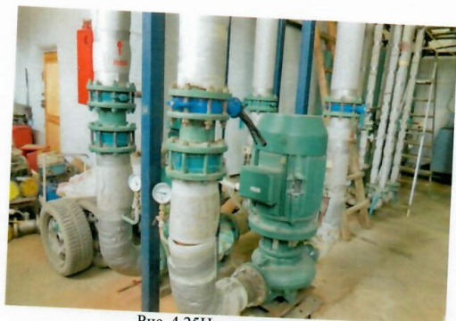
Рис. 4.25 Насосы сетевые
