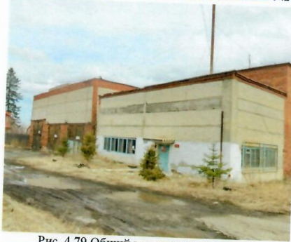
Рис. 4.79 Общий вид здания котельной
