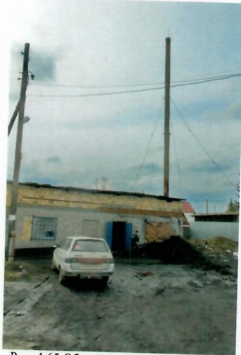
Рис. 4.65 Общий вид здания котельной
