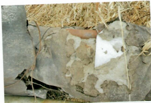
Рис. 4.133 Разрушение теплоизоляции
