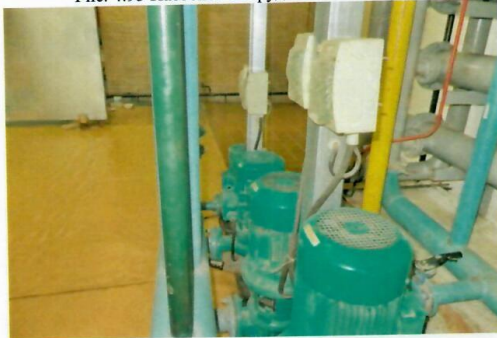
Рис. 4.95 Сетевые насосы
