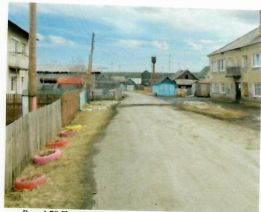
Рис. 4.78 Подземная теплотрасса, проход под дорогой
