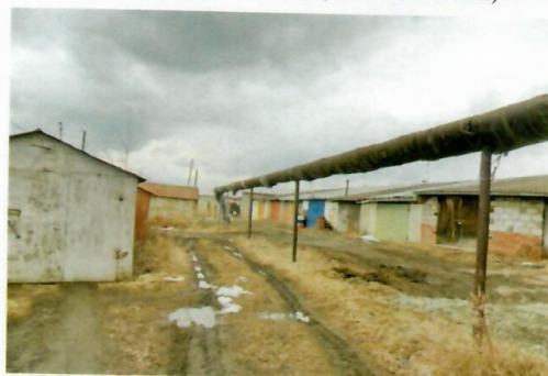
Рис. 4.59 Надземный участок магистральной теплосети
