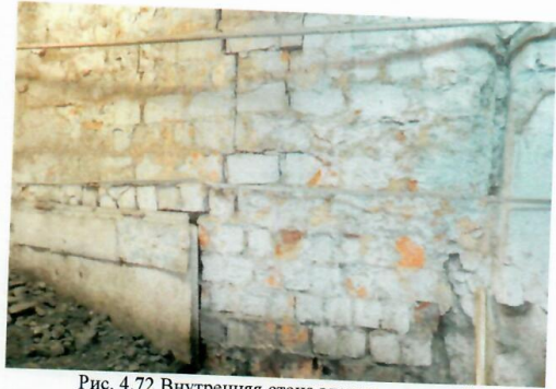
Рис. 4.72 Внутренняя стена здания котельной
