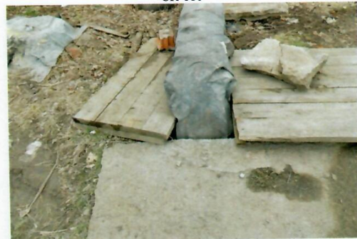
Рис. 4.100 Колодец магистральный тепловой сети
