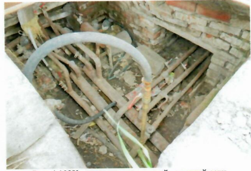
Рис. 4.102 Колодец магистральный тепловой сети
