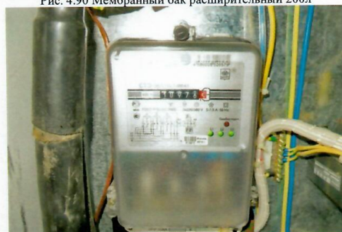
Рис. 4.92 Прибор учета электроэнергии
