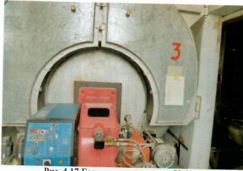
Рис. 4.17 Горелка газодизельная Unigas
