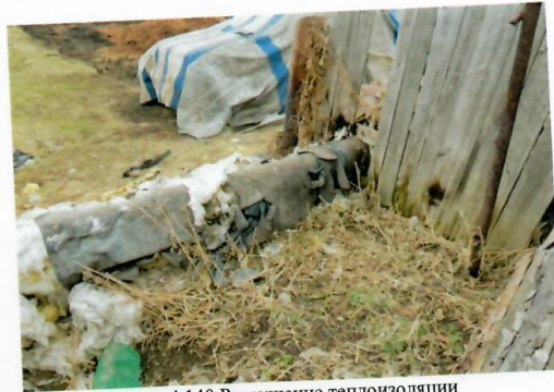
Рис. 4.140 Разрушение теплоизоляции
