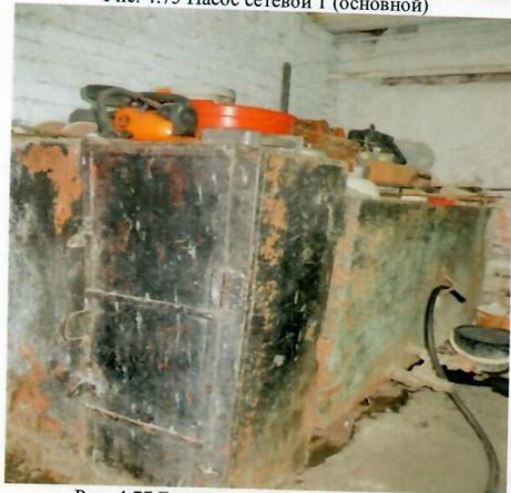
Рис. 4.77 Емкость стальная для подпитки
