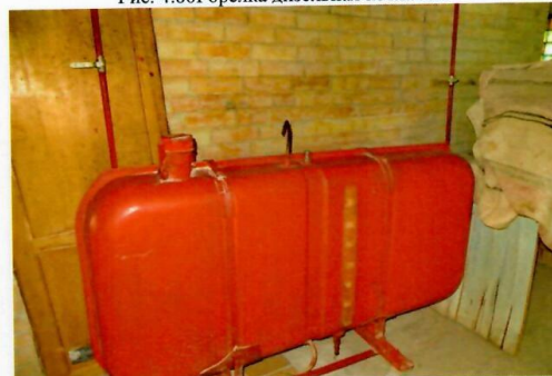
Рис. 4.88 Емкость для резервного топлива (не используется)
