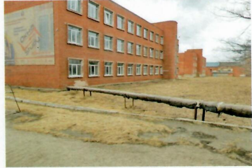
Рис. 4.106 Надземная теплотрасса. Ввод в здание училища
