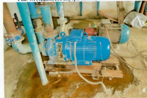
Рис. 4.112 Насосы сетевые
