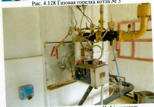
Рис. 4.130 Газовая горелка котла № 4 (двигатель демонтирован)
