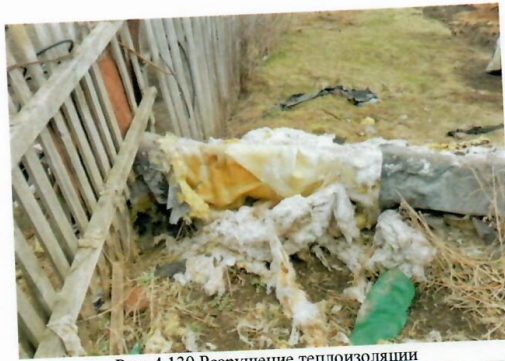
Рис. 4.139 Разрушение теплоизоляции
