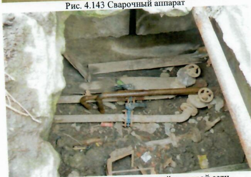
Рис. 4.145 Колодец магистральный тепловой сети
