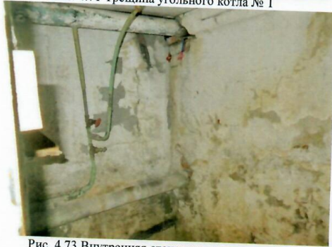
Рис. 4.73 Внутренняя стена здания котельной
