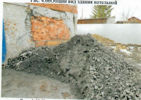
Рис. 4.68 Площадка хранения каменного угля
